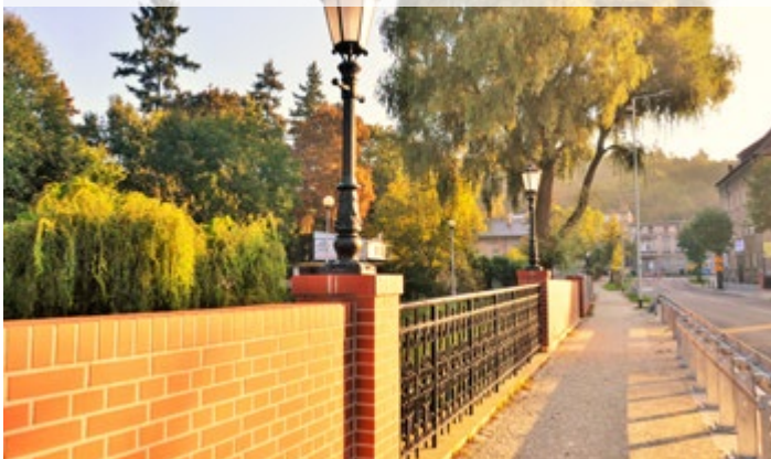
Ul. Borowskiego gotowa po remoncie
