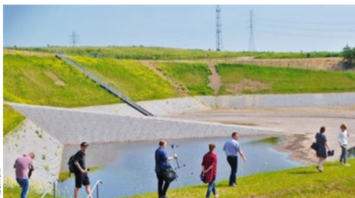
System odprowadzania wód opadowych w zachodniej części Gorzowa (zrealizowany z oszczędnością ponad 40 mln)
