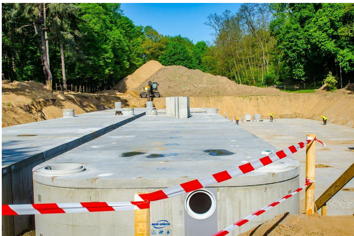
Zbiornik w Parku Słowiańskim – etap budowy, kontrakt III – etap I, Fot. Łukasz Kulczyński
