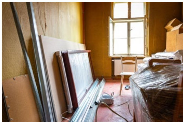
Remontowany lokal przeznaczony na mieszkanie chronione
