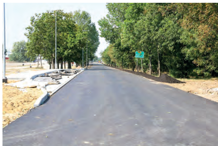
Wyremontowany fragment ulicy Szczecińskiej
