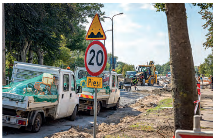
Remontowana ulica Śląska
