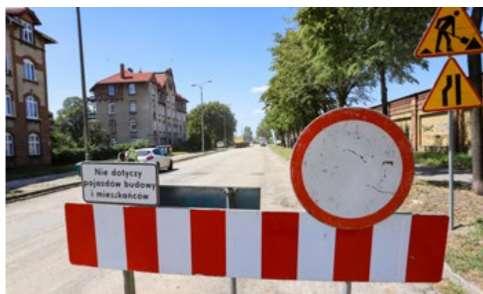
Remontowana ul. Śląska
