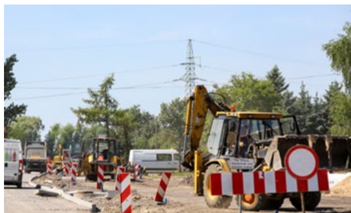
Remontowana ul. Śląska
