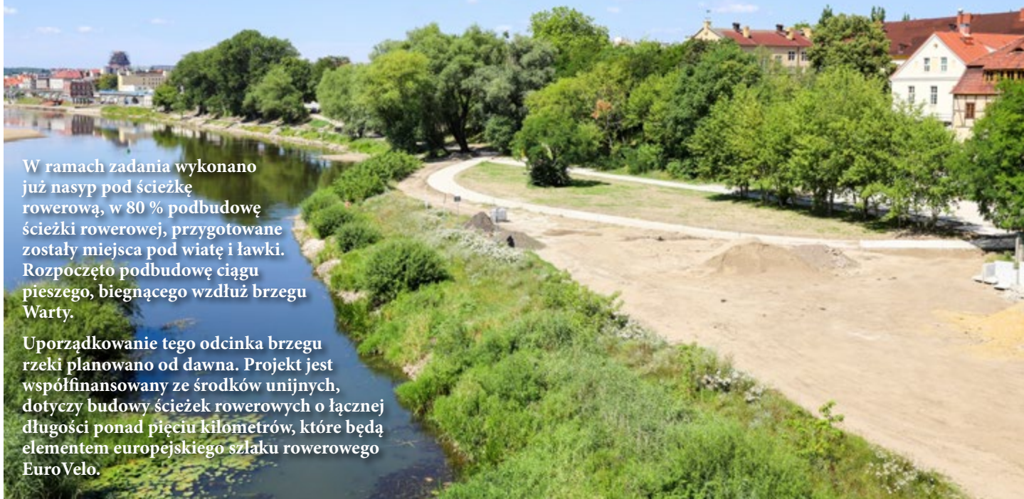
Budowa ścieżki pieszo-rowerowej wzdłuż Warty
