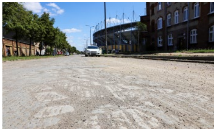
Remontowana ul. Śląska
