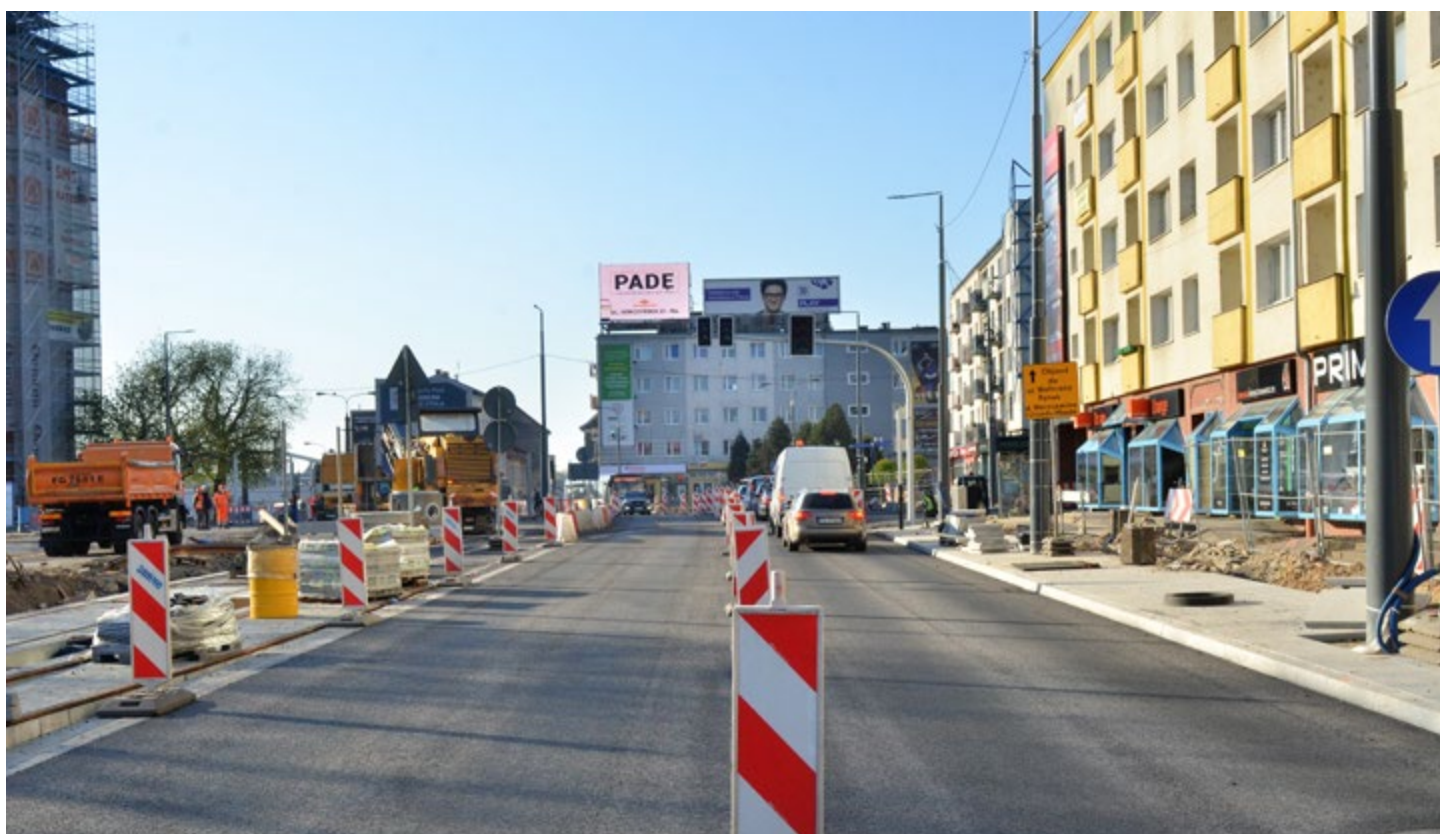
Remontowana ulica Sikorskiego
