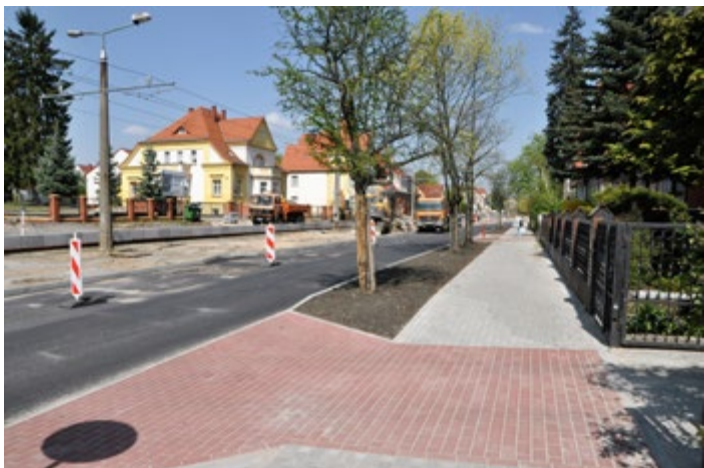
Remontowana ulica Kazimierza Wielkiego
