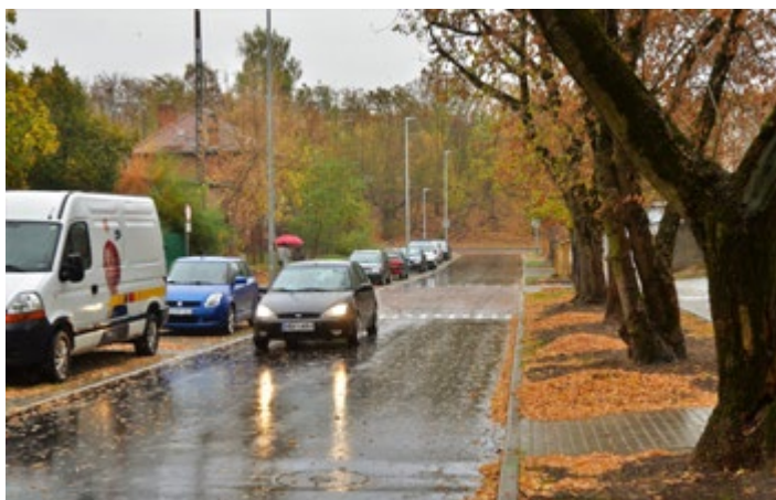
Wyremontowana ul. Gwiaździsta
