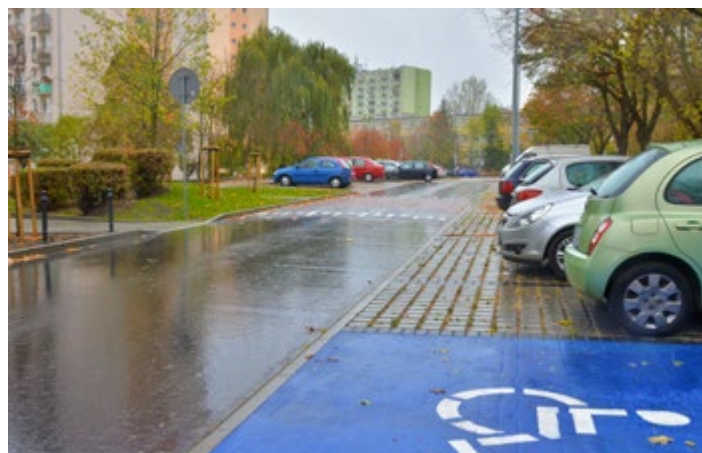
Wyremontowana ul. Gwiaździsta
