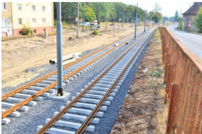
Torowisko przy Al. 11 Listopada
