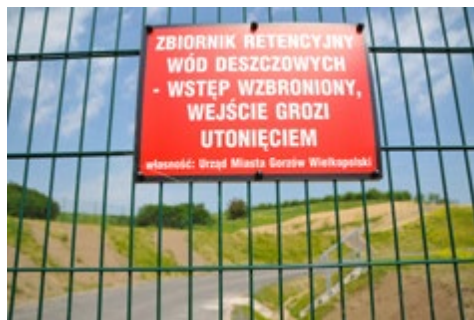
System odprowadzania wód opadowych w zachodniej części Gorzowa
